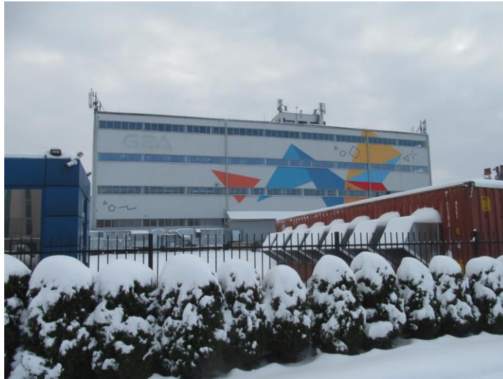
Zał. nr 1: Widok ogólny instalacji radiokomunikacyjnej.
